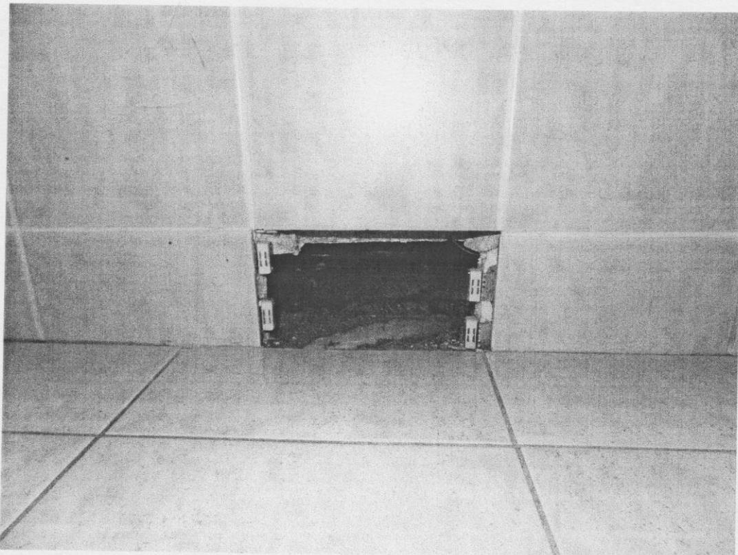
Bild 63: Öffnung zur Revision der Abwasserleitung und des Siphons
